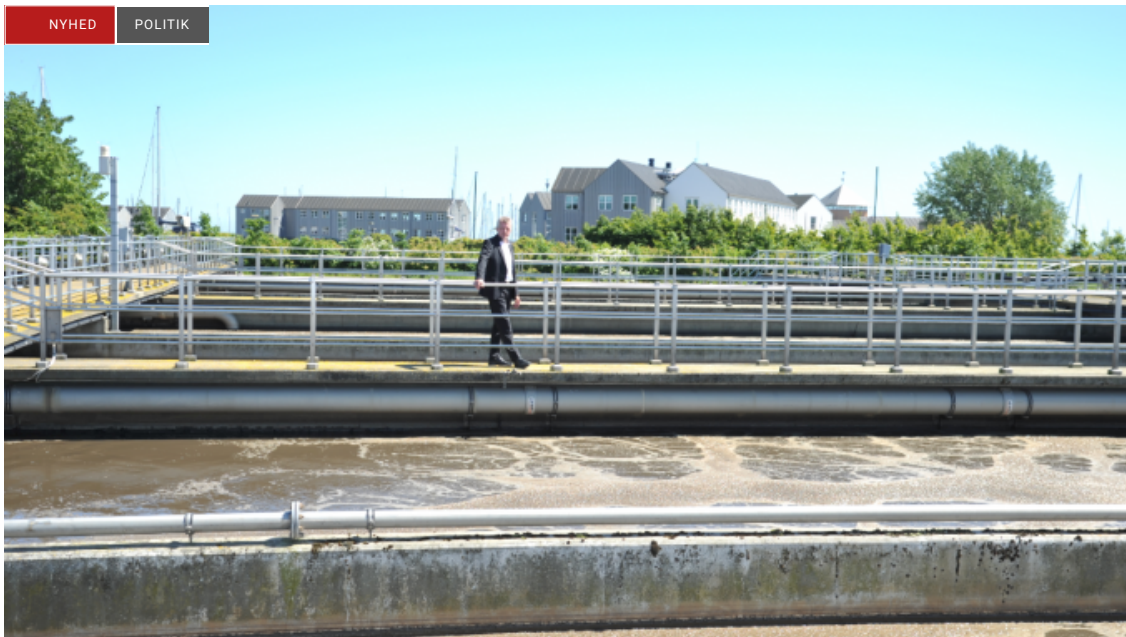
Marselisborg Renseanlæg er med en energiproduktion på 234 pct. af den forbrugte energi verdens mest energieffektive renselanlæg. Foto : Danfoss
