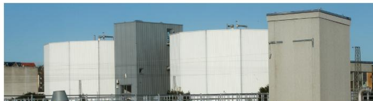
Rådnetanke på Marselisborg Renselanlæg, hvor der dannes biogas af spildevandet.
